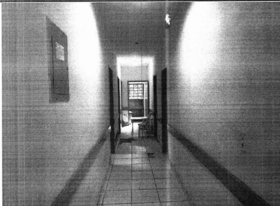
FOTO 09 - Corredor de acesso aos fundos da edificação
