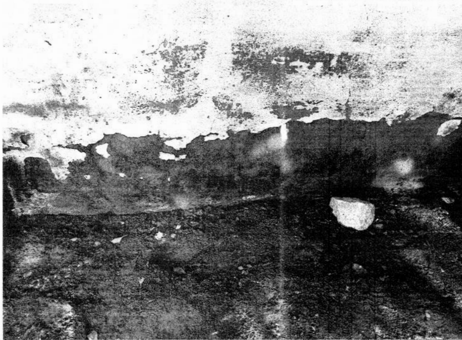
FOTO 13 - Umidade nas Paredes
