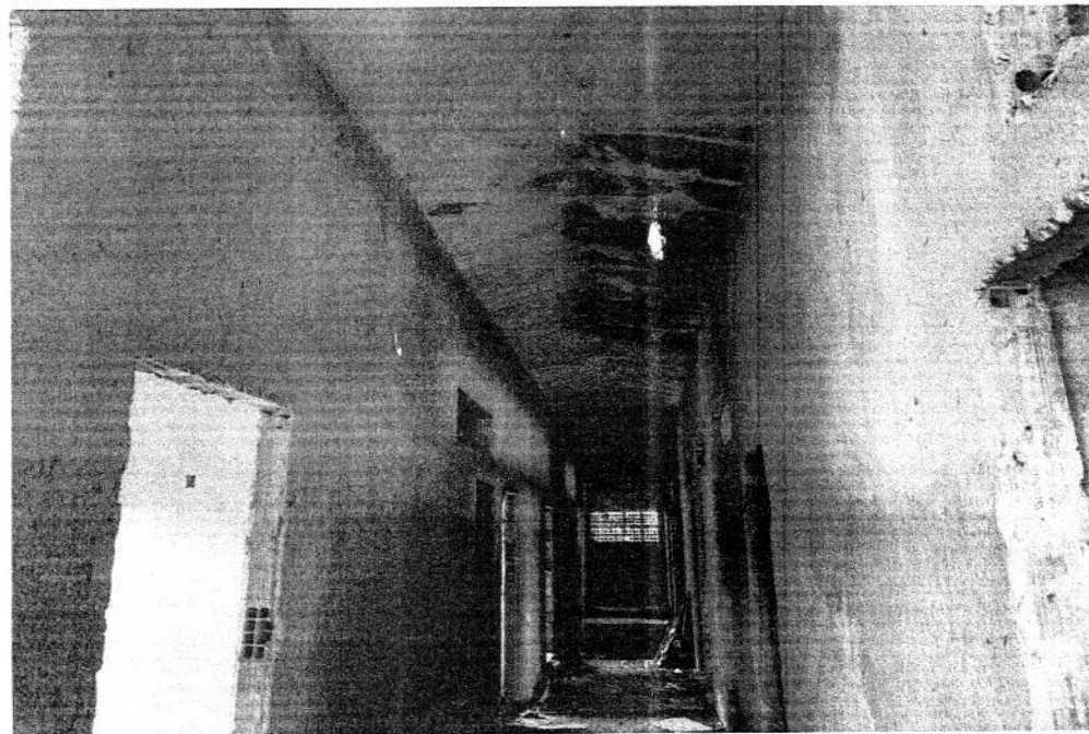
FOTO 04 - Corredor de Acesso
